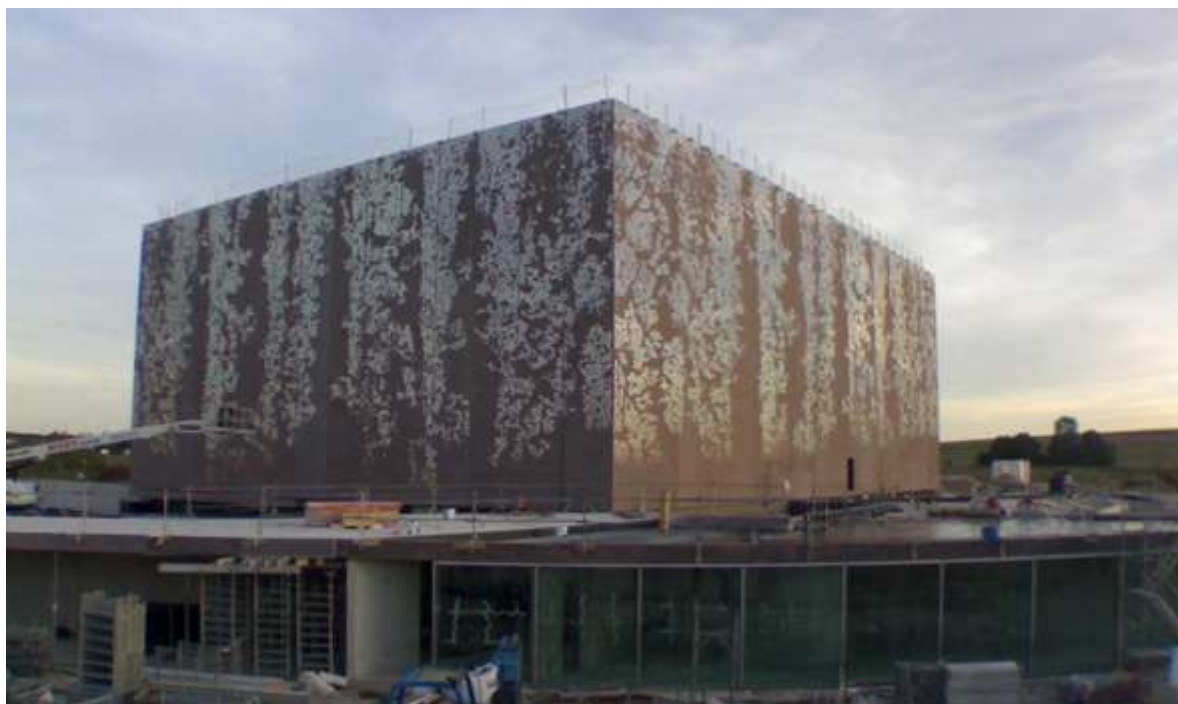
Widok na segment magazynowy, u dołu pomieszczenia biurowe, sala szkoleniowa
